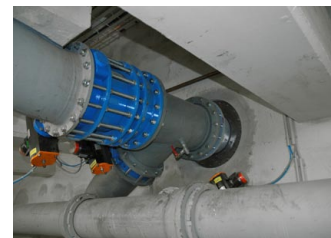
Rohrleitungen am Zu- bzw. Ablauf Sanierte Rohrleitungen am Filterbecken.
