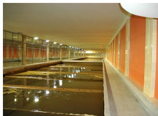
Gefülltes Filterbecken Nachdem Füllen des Filterbeckens, wird das Rohrleitungssystem auf Dichtheit geprüft.
